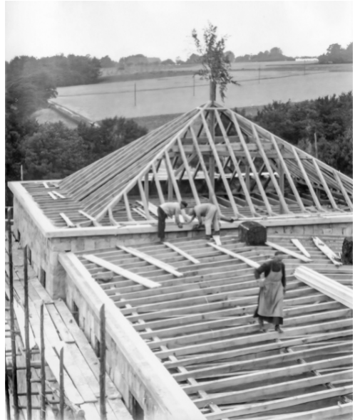
Richtfest auf dem neuen Pfortenflügel, August 1932
