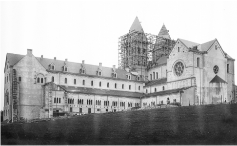
Kirche und Kloster im Bau (vor 1904)
