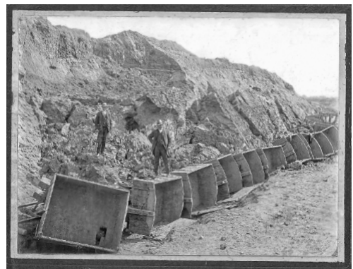
Tonnen über Tonnen Sand, Geröll, Erde und Oberbaumaterial mussten ab- und antransportiert werden. © Stadt Billerbeck
