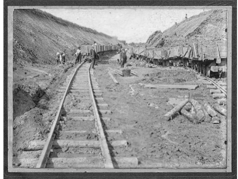
Falls es zum Bahnbau gekommen wäre, hätten jede Menge Erdarbeiten per Hand erledigt werden müssen - wie bei Billerbeck 1906. © Stadt Billerbeck
