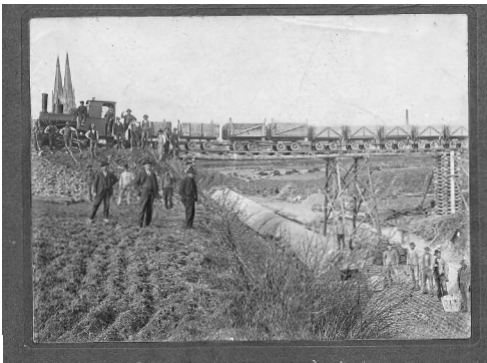
Bau der Baumbergbahn - Billerbeck 1906 © Stadt Billerbeck
